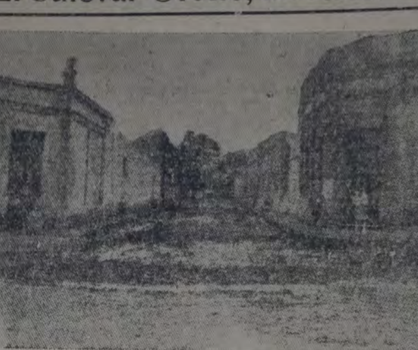
EN SU PROLONGACION HACIA EL SUD, A LA ALTURA DE LA CALLE VIRASORO, presenta el aspecto que señala la nota gráfica, característico, por lo demás, de los barrios suburbanos de la segunda ciudad de la república. En el caso que nos ocupa debe señalarse que la calle en cuestión sólo queda a cuatro cuadras del límite sud del parque Independencia. No pasan los carros de la municipalidad y los desperdicios domiciliarios se amontonan en la calzada. El diario "La Capital" ha publicado, a este respecto, interesantes informaciones gráficas.
